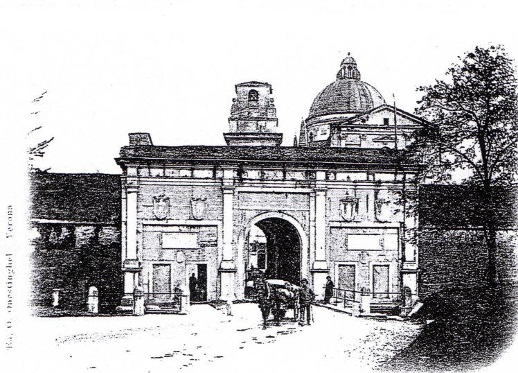
VERONA - Porta S. Giorgio. Facciata esterna. Arch. Toscano-Dorica dell'Anno 1825.
